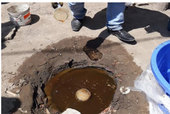
FIGURA33: vista a las 24h de biodigestor al que se le adicionó 100 litros de probióticos
