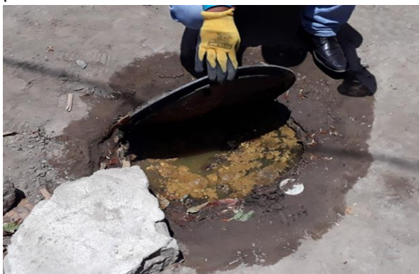
FIGURA 2: estado situacional del biodigestor instalado en para tratamiento de agua residual domestica rural en el Centro Poblado Santeño –Tumán
